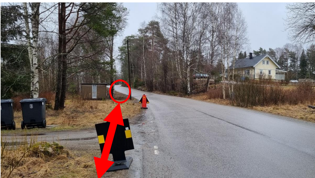
Figur 11 Teknikhus och infart till fastighet 11:1
