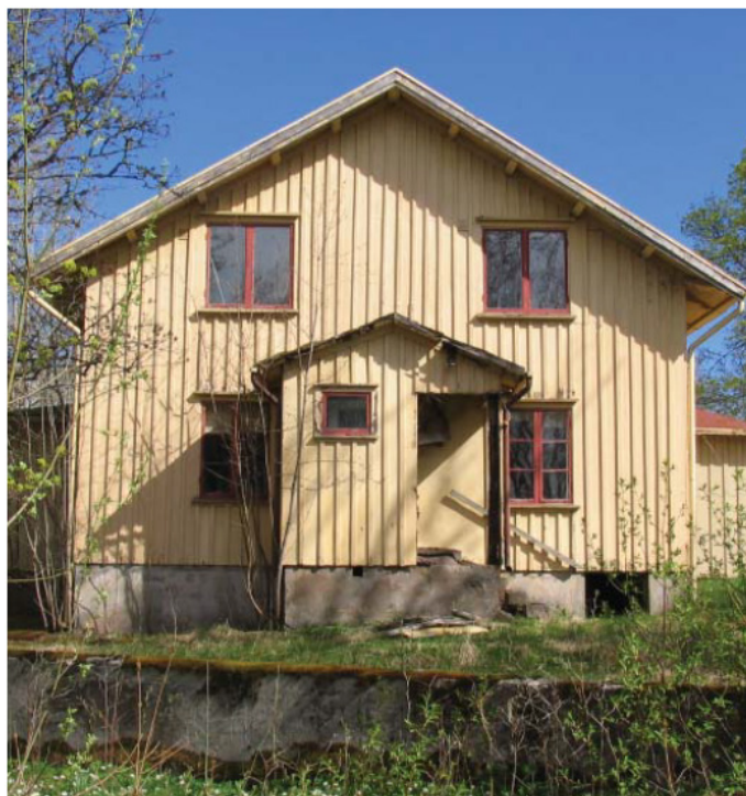
Huvudbyggnaden med farstu mot norr
