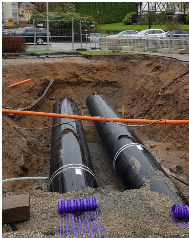
Figur 5. Ledningsschakt på sydvästra del av aktuellt undersökningsområde. (källa: FFU, Borås Stad, 2018)
