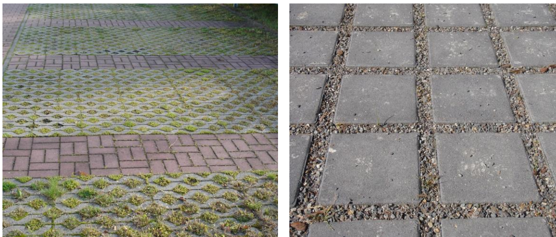
Figur 22. Två exempel på genomsläppliga markstensbeläggningar. Till vänster: Hålstensbeläggning på den del av parkeringsplatsen som hamnar direkt under en bil. Till höger: markstensbeläggning med genomsläppliga fogar. Foto: WRS
