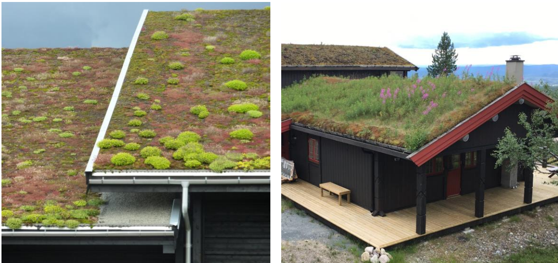
Figur 18. Två exempel på byggnader med gröna tak. Foto: WRS.
