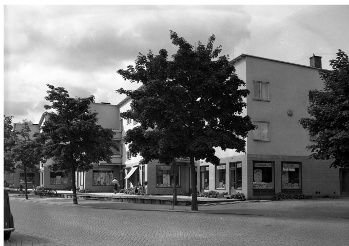
Byggnaderna längs med Alingsåsvägen har historiskt sett varit präglad av verksamhetslokaler i bottenplan.
